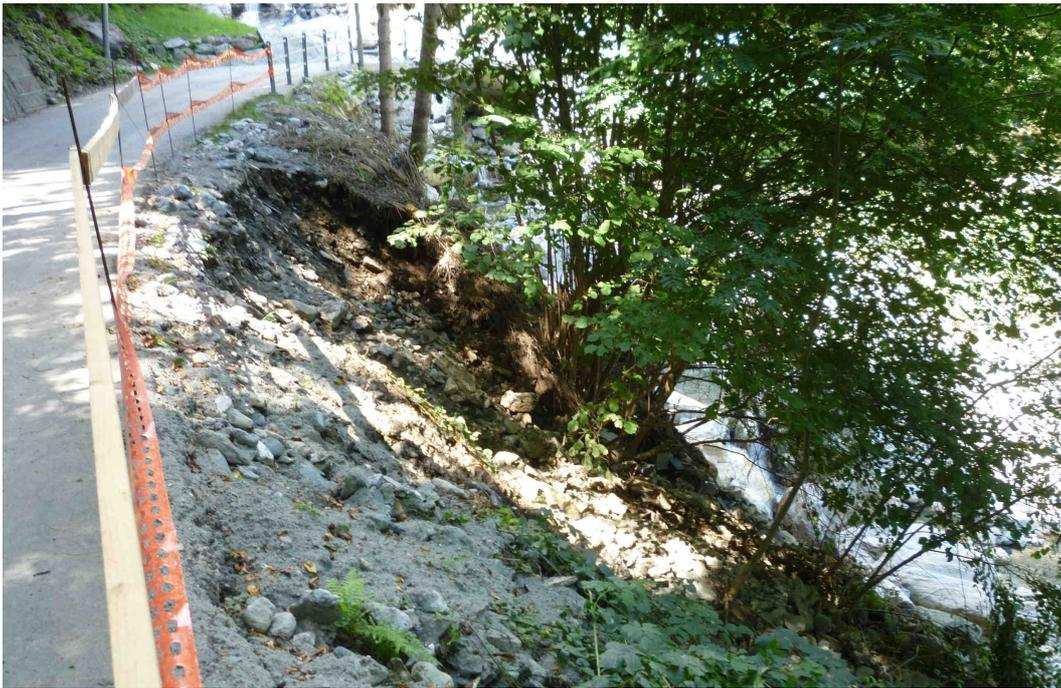
[dettaglio della sponda destra erosa e danneggiata a valle del ponte](#)
